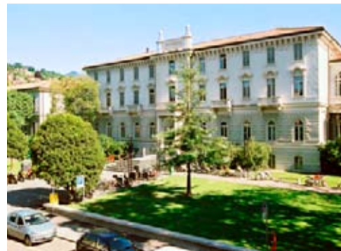
Hauptgebäude (ehemaliges Spital)
